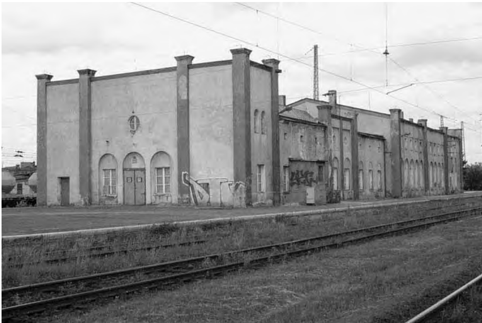
Fot. 1. Przebudowany budynek dworca wyspowego z 1843 r., widok od strony Świebodzic.
