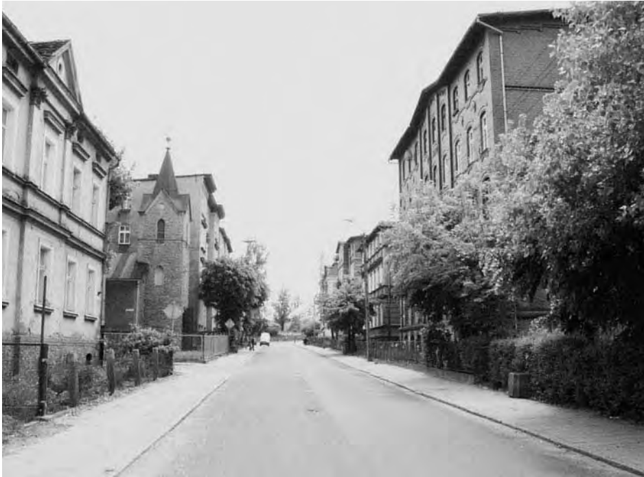
Fot. 2. Zabudowa kalenicowa w biegu ob. ul. Westerplatte, z lewej widoczny dawny kościół.
